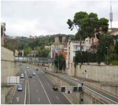
RONDA DE DALT Túneles de Vallvidrera
