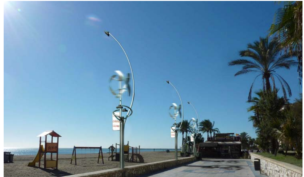
Próxima instalación de alumbrado público alimentado con energía micro eólica, en el Pº Marítimo Antonio Banderas
